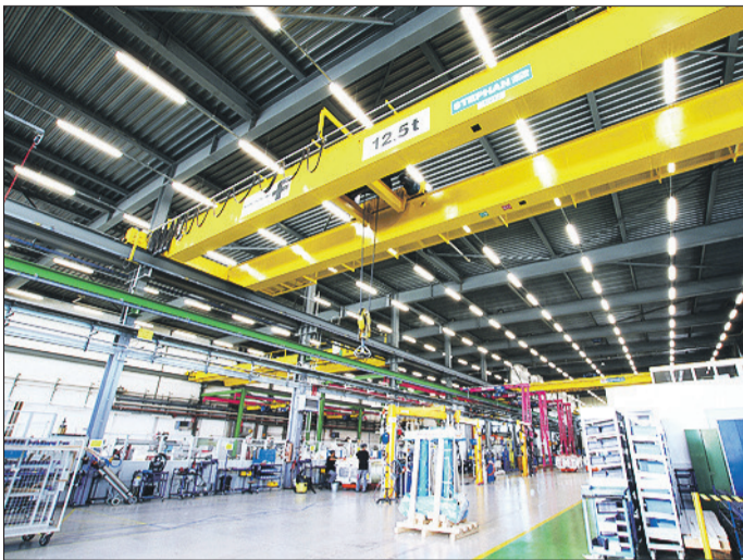
ABB SÉCHERON. Les luminaires dont l'éclairage s'adapte à la lumière naturelle ont fait baisser la consommation de 65%.
